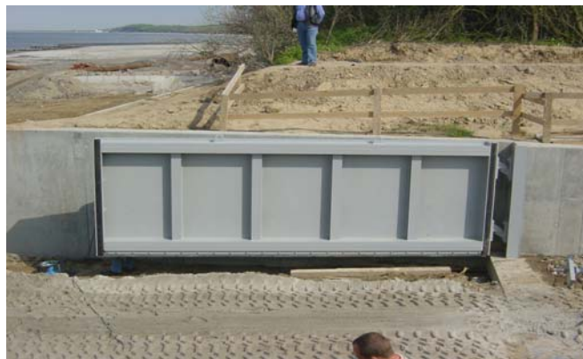
Flutturflügel: 5 m lang, 1,8 m hoch
