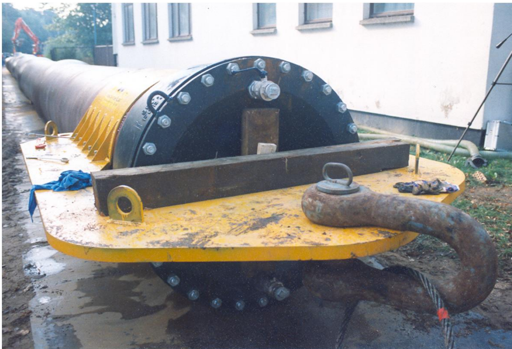
Zugvorrichtung für 342 m lange DN 1000 Leitung
