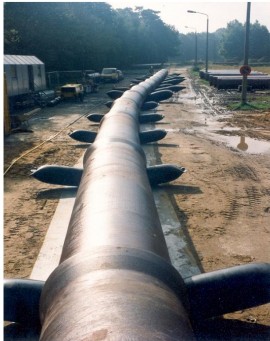
Vorbereitung Einziehvorgang landseitig
