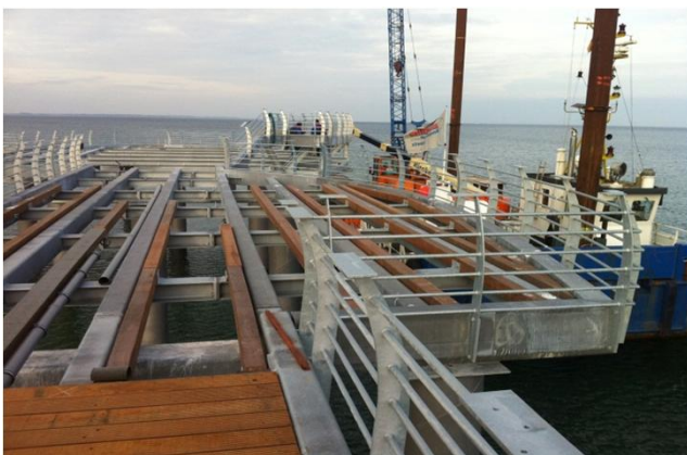
Rohbau: Montage mit Schiff
