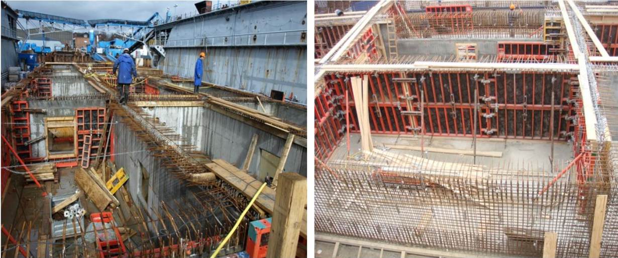
Schal- und Bewehrungsarbeiten der Pontonkammern im Trockendock
