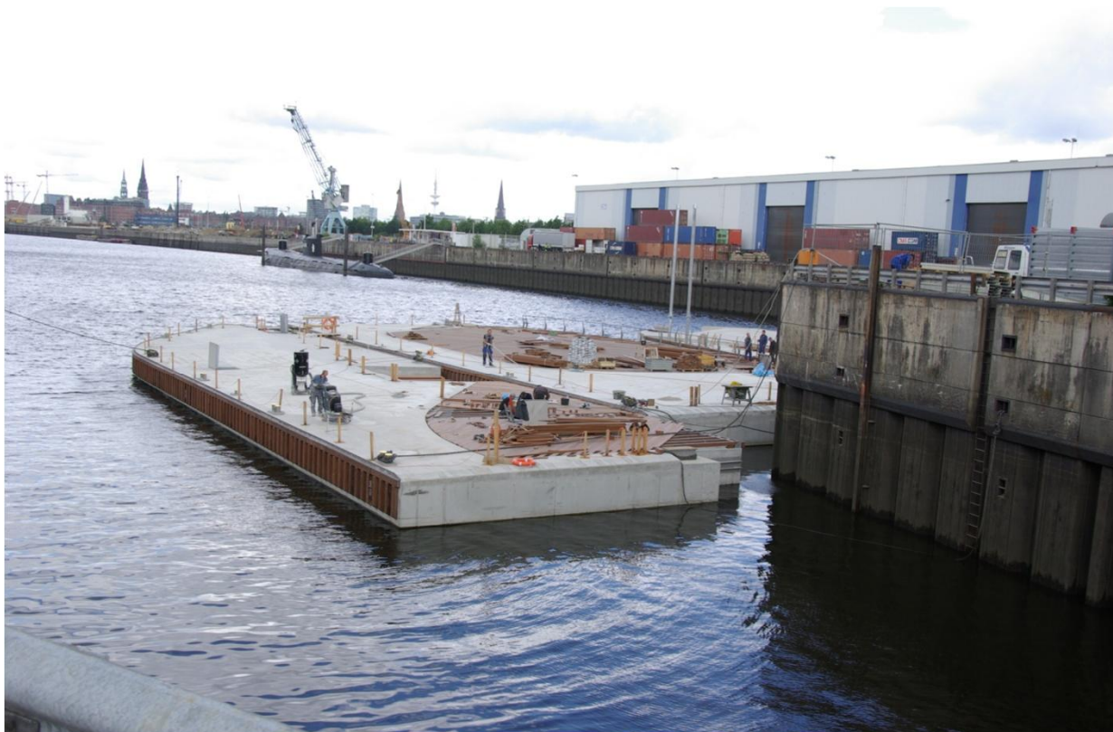
Ausschwimmvorgang aus Trockendock
