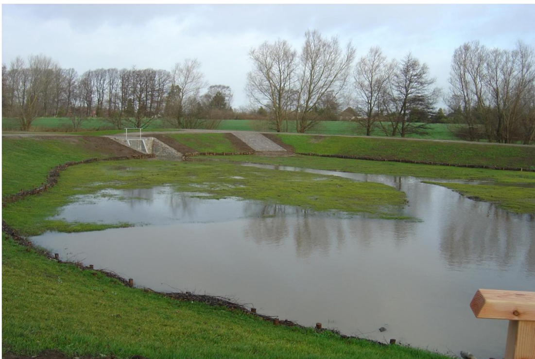
Becken 1 mit Drosselbauwerk
