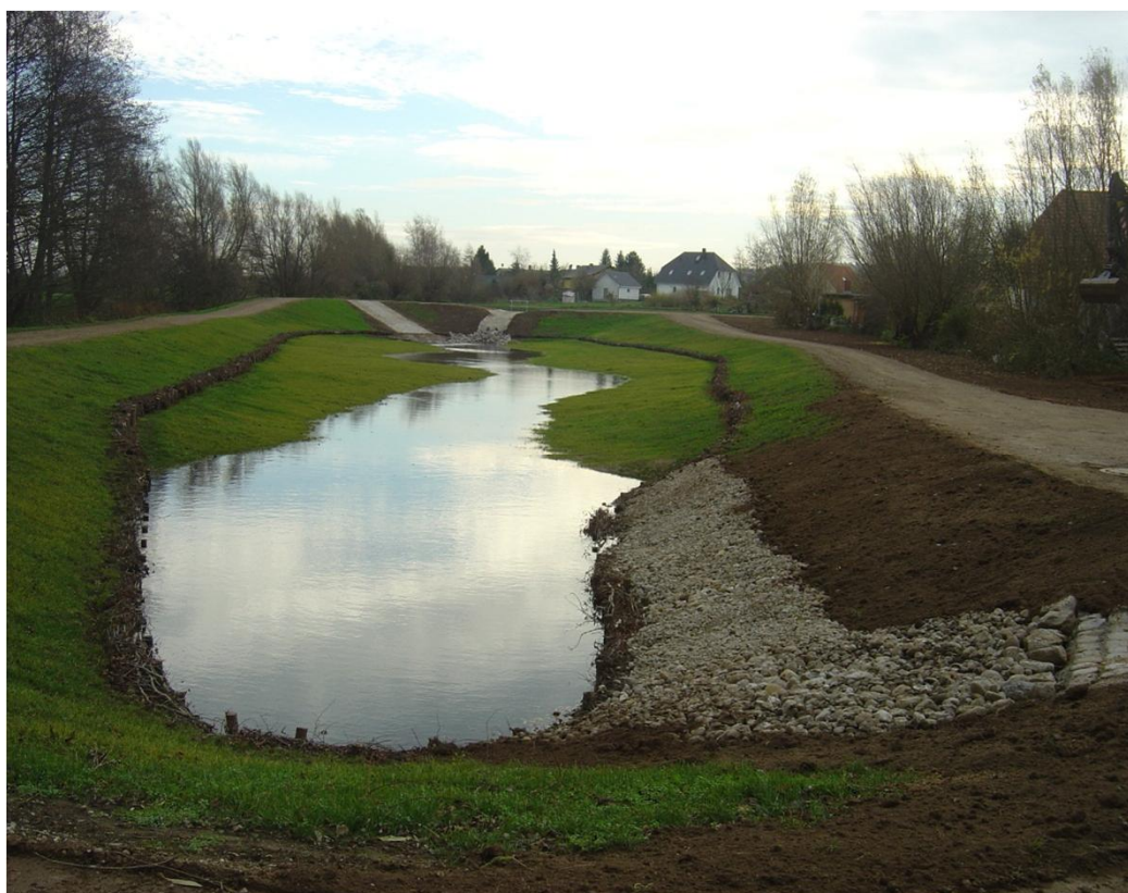
Fertiggestelltes Becken Nr.2
