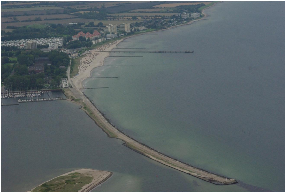
Luftbild des Strandabschnittes Großenbrode nach Bühnenbau
