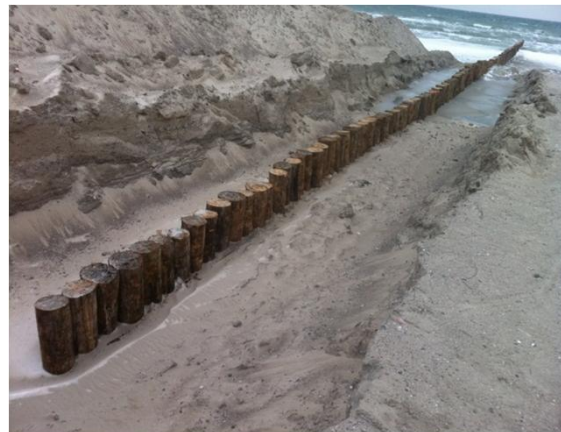
Holzbühnenanschluss im Strandabschnitt
