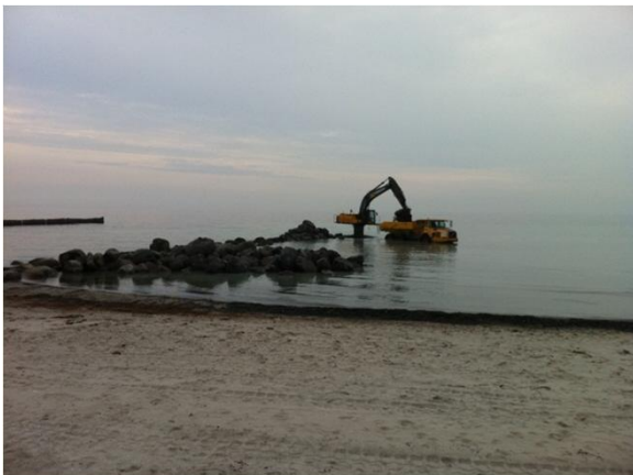
Rückbau von funktionslose Steinbühne
