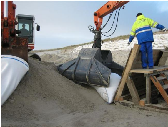
Sandcontainer, Einbau in Schutzdüne
